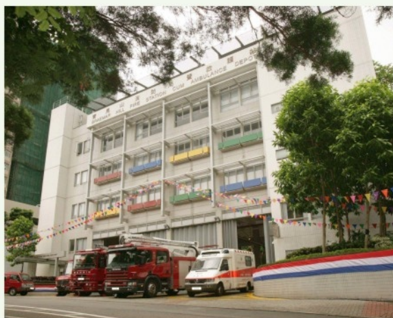
● 寶馬山消防局暨救護站
